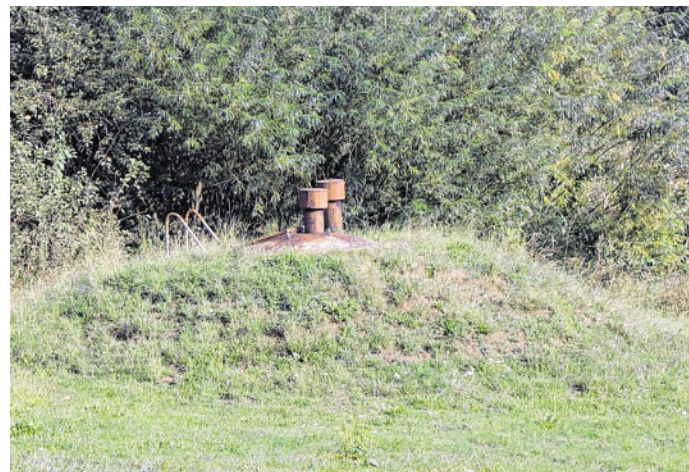
Hier verbirgt sich einer von insgesamt acht Brunnen.
